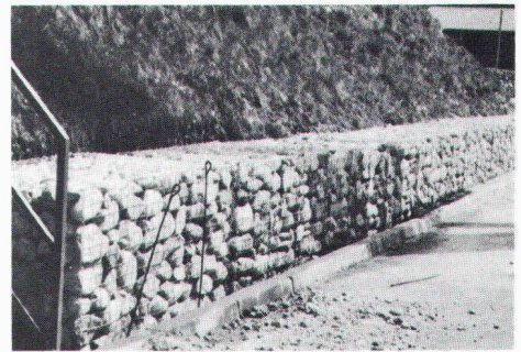
Beispiel einer Böschungverbauung
