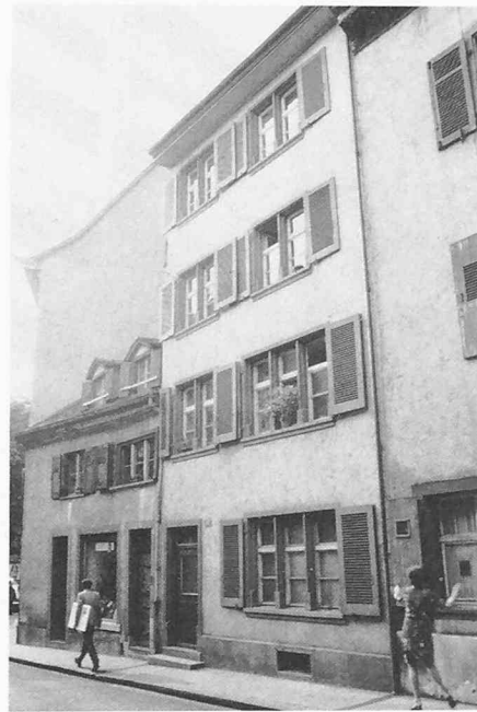
Rheingasse 65+67, Strassenfassade, vor der Sanierung
