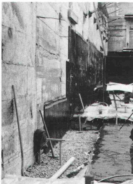
filterstabilen Sickermatte Enkadrain, die überall dort eingesetzt wird, wo aus bautechnischen und wirtschaftlichen Gründen ohne Raumverlust gegen das Terrain (Fels, Rühlwand usw.) betoniert wird. Enkadrain CK besteht aus
