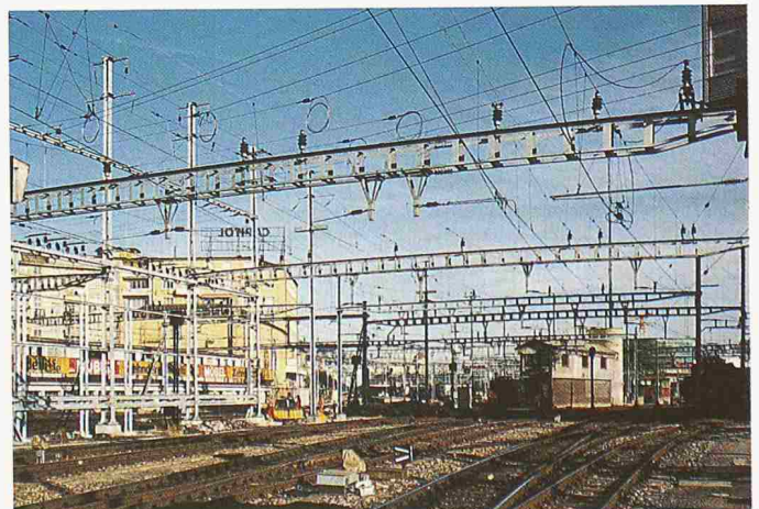
Bild 3. Schaltposten im Bahnhof Luzern im Bau. Die einzelnen Sektoreinspeisungen sind vorbereitet (Ringe an Quersaiten) (Foto J. Brun, Luzern)
