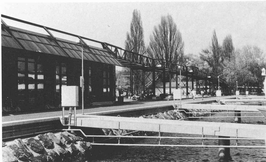
Bild 7. Uferböschung mit Alpenkalk-Blocksatz, vorgefertigtem Versorgungskanal und Hafenstege. Dahinter die Fassade des Betriebsgebäudes und der Seeuferweg
