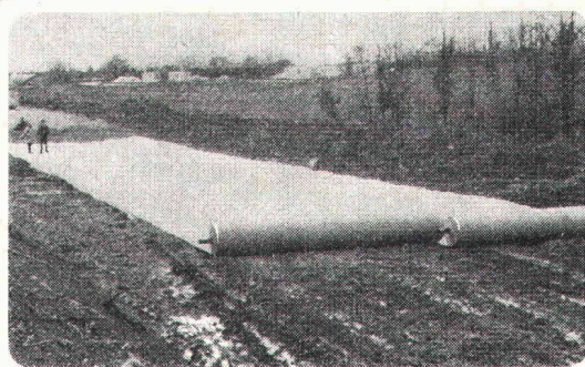
Abrollen der Matte, Vorkopf- aufschüttung
