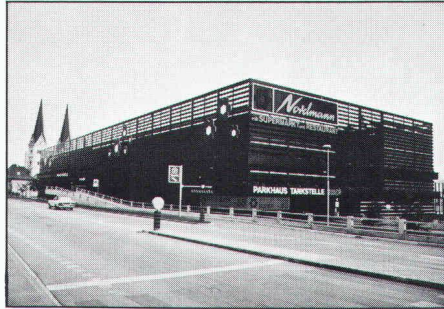
Traggerippe eines Handelszentrums mit Parkebene im Untergeschoss
