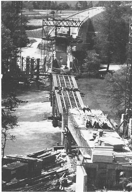
Bild 3. Bauzustand der Aarebrücke Ruppoldingen der SBB im Jahr 1978 mit allen 3 Bauphasen (nach [1])
