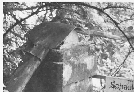
Detail eines Pylonsattels mit gusseisernem Zylinder
