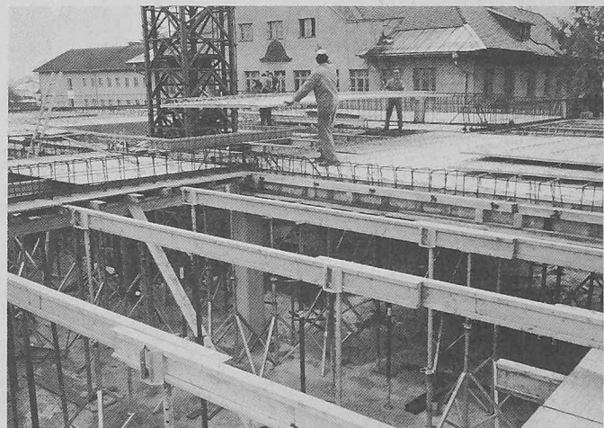
Bild 1. Fertigteildecken mit System Dokaflex 20
