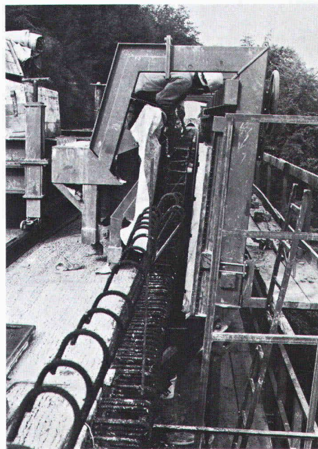
Bild 6: Die über das Innenschalungselement gezogene Vliesmatte muss straff angezogen werden, um jede Faltenbildung zu verhindern.
