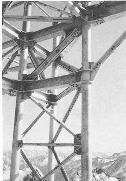
Bild 9. Antennenträger: Rahmenknoten mit Dreieckriegeln und Anschluss einer Terrassenkonsole
