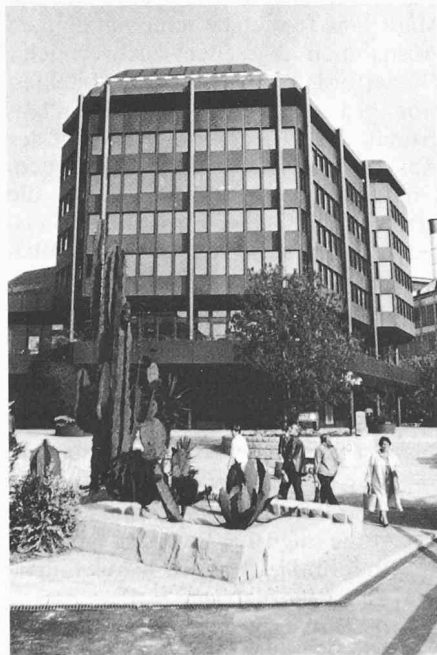
Bild 8. Bürotrakt von Norden, Haupteingang
