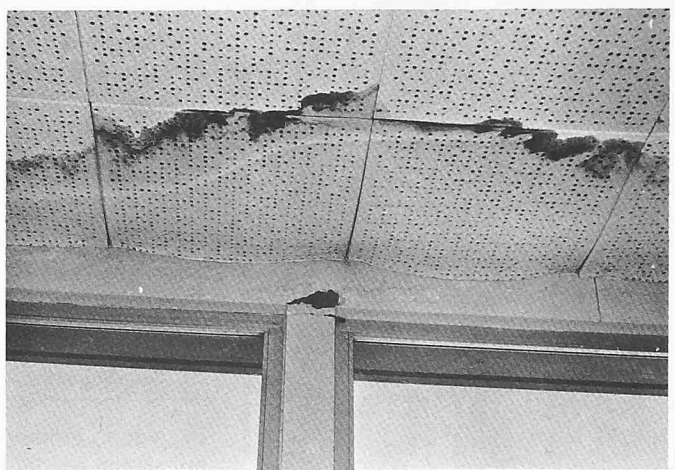
Bild 2. Decke im Innern des grössten Gebäudes aus Bild 1
