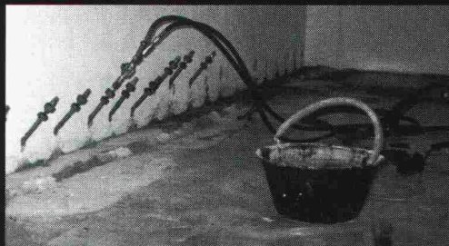
Elastische Abdichtungs-Injektion-Rascoflex in einer Zivilschutzanlage.
