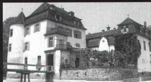
Rascolit-Flächenabdichtung und Horizontalsperre gegen aufsteigende Feuchtigkeit (Weiherschloss Bottmingen).
