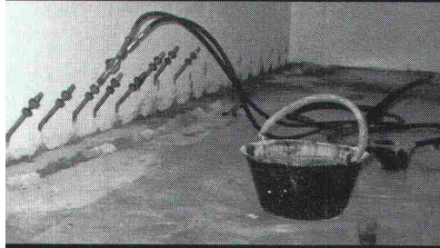
Elastische Abdichtungs-Injektion-Rascoflex in einer Zivilschutzanlage.
