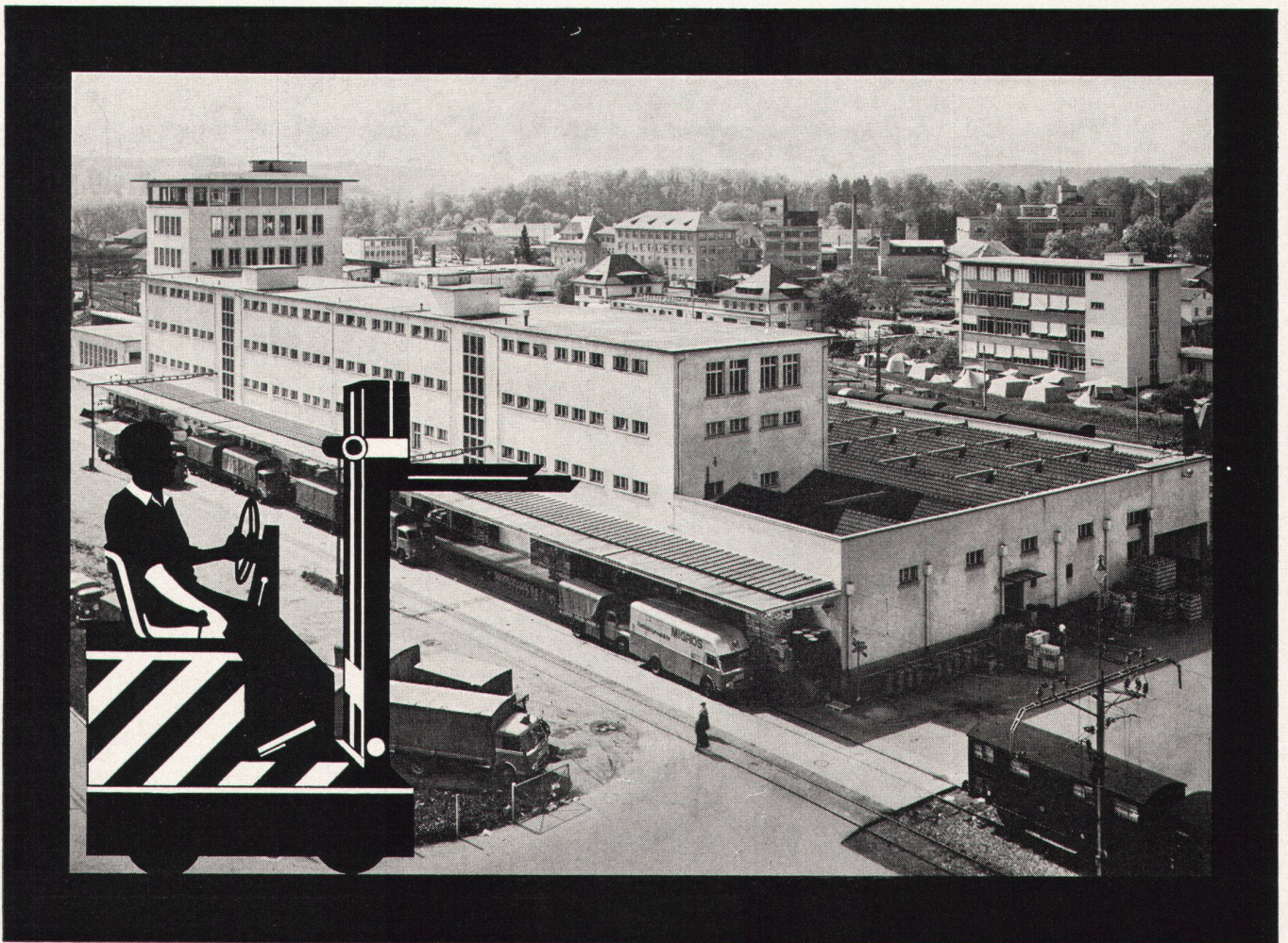
Migros-Lagerhaus, Bern: Klimaanlage der WERA AG
