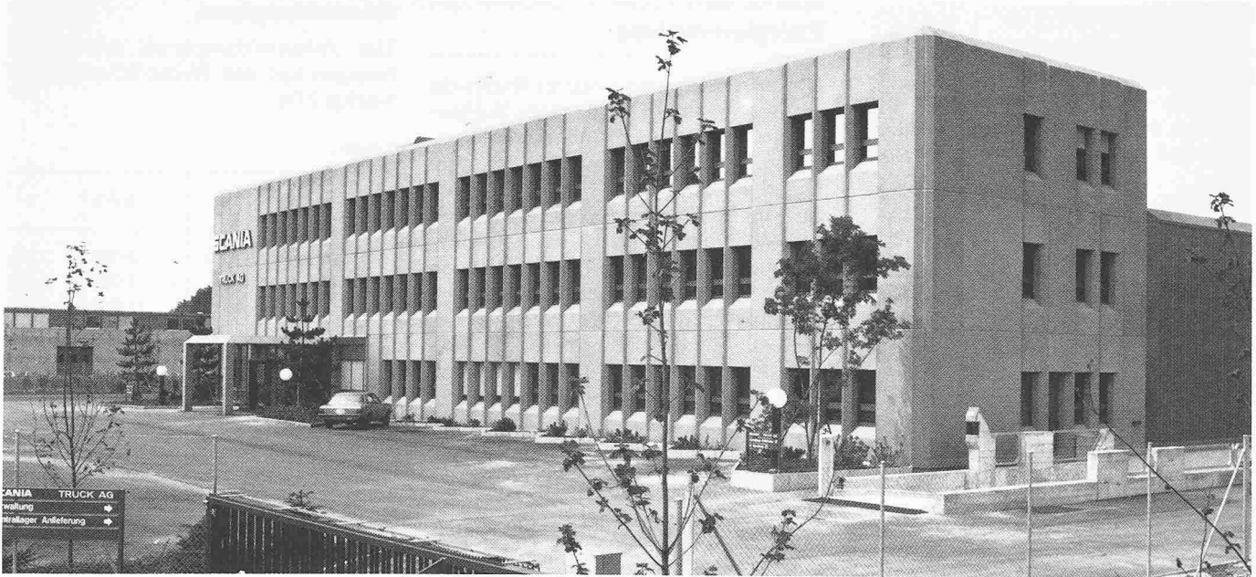
Ansicht des Bürotraktes von Südosten
