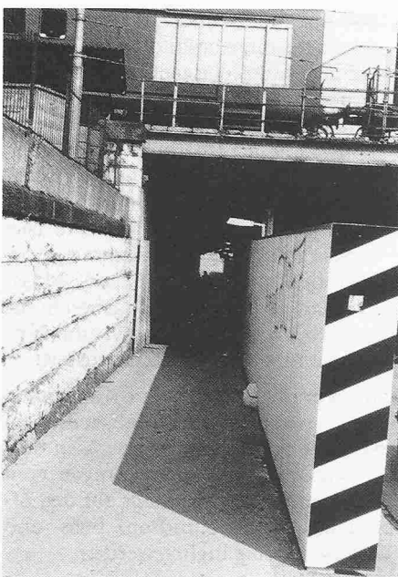
Bild 9. Fussgängerverbindungen sollten sicher und attraktiv sein. Sie sind zur Absicherung gegen Energiekrisen im Verkehr und als Beitrag zur Verkehrs-sanierung im Nahbereich unerlässlich
