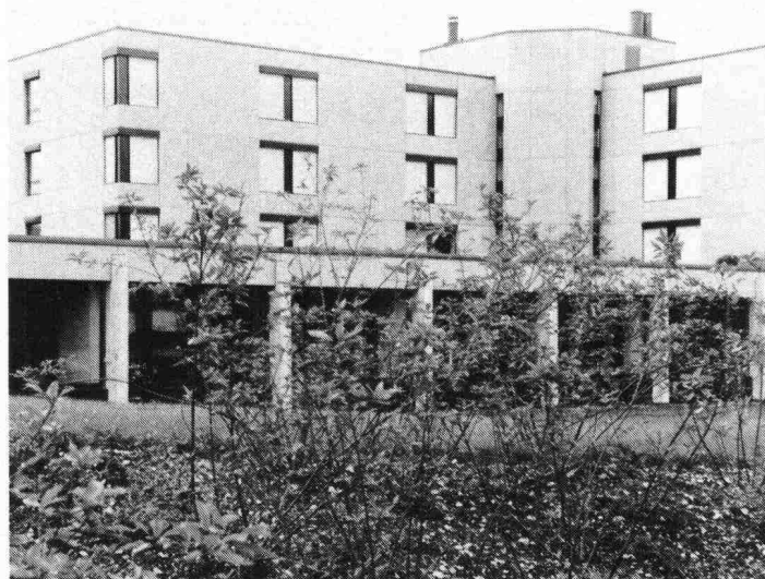
- Ausbildungszentrum Bâloise Münchenstein. Innenisolation.
