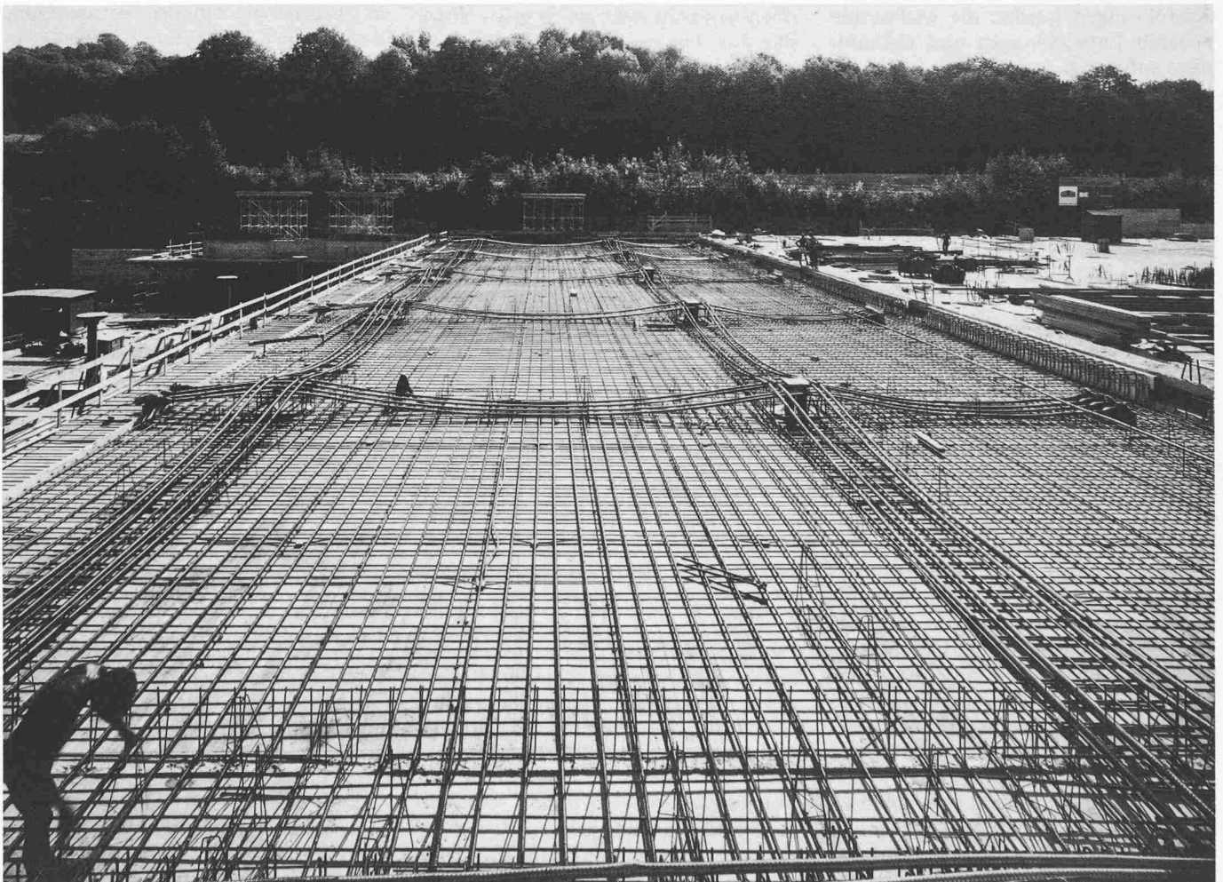
Bild 1. Stützstreifen-Vorspannung (obere Bewehrung noch nicht verlegt)
