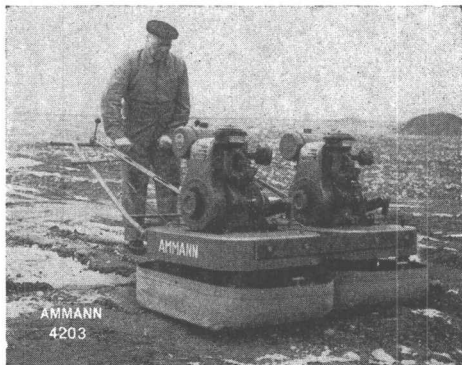
Zwei Bodenverdichter Nr. 5 gekuppelt
