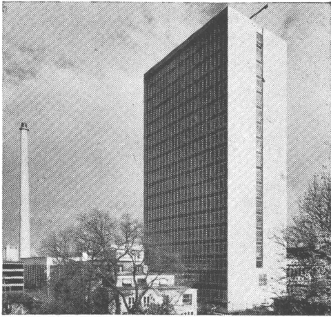
Im Hochbau für hohe Festigkeiten
