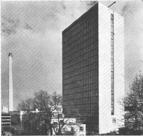
Im Hochbau für hohe Festigkeiten
