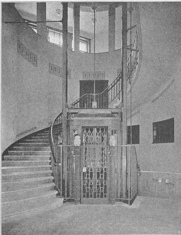
Abb. 8. Die Banktreppe im Erdgeschoss.
