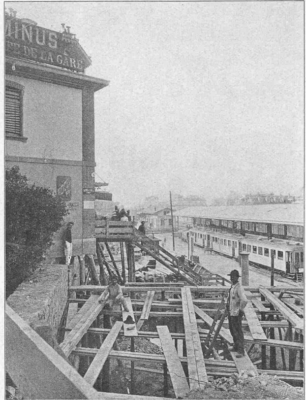
Abb. 7. Unterfangen der Ecke des Hauses Nr. 3.
