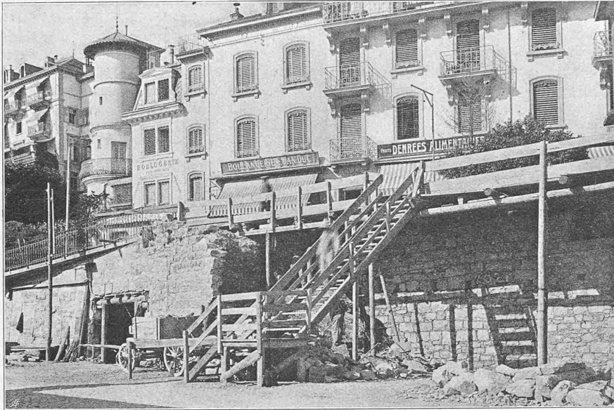
Abb. 5. Stollen für das linke Widerlager (B-B in Abb. 4) des Tunnels unter dem Hause Nr. 2.
