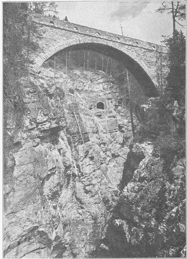
Abb. 19. Gewölbte Brücke der Zufahrtsstrasse nach Jennisberg und unteres Portal des Wiesener Tunnels II.
