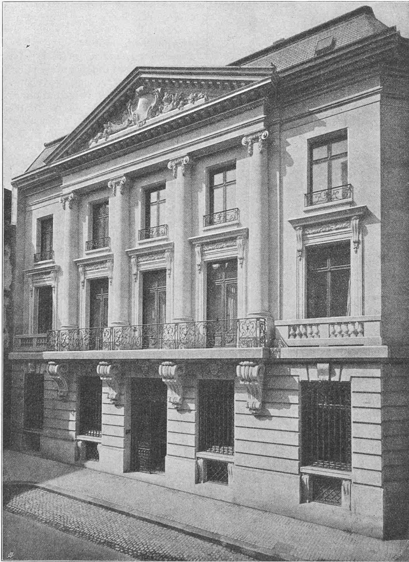
Abb. 5. Fassade an der Freiestrasse.
