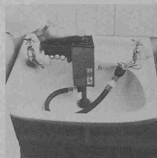
Die Druckwellen werden weder durch Lüftungsrohre, Abzüge noch Rohrbogen in ihrer Wirkung beeinträchtigt, und da lediglich 2 Prozent der Energie auf die Seiten einwirken, entsteht selbst an weniger stabilen Rohren keinerlei Schaden. Der gesamte Vorgang dauert nur wenige Minuten.
