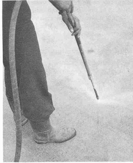
Bild 9. Reinigung der Betonoberfläche mit Hochdruckwasserstrahl (750 bar)
