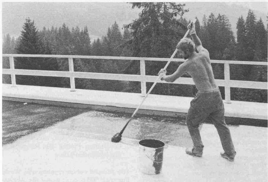
Bild 11. Auftragen der Abdichtung Efkaprene von Hand
