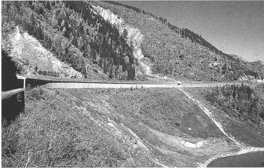
Lawinenschäden des Winters 1999 an der Verbindungsstrasse Martina-Vinadi im Unterengadin: zerstörter Bannwald (Bild: Comet)
