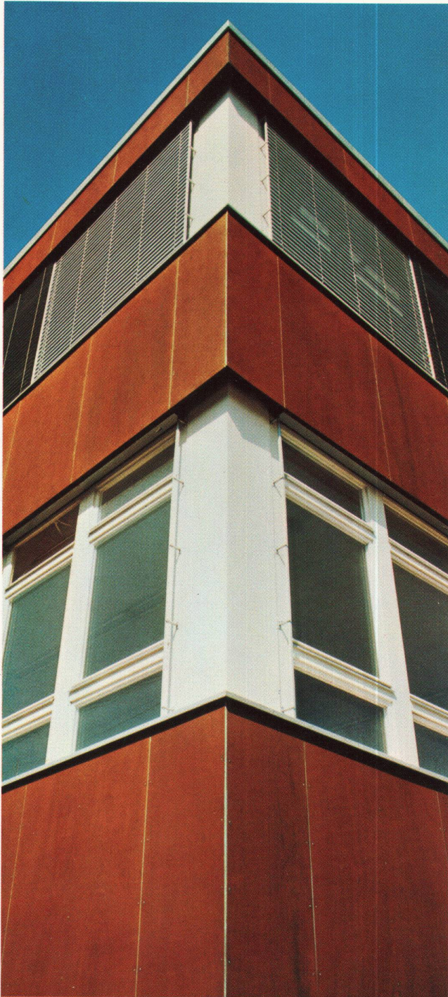
Industriegebäude: Gebr. Gläser AG, Schreinerei, 5513 Dättwil
