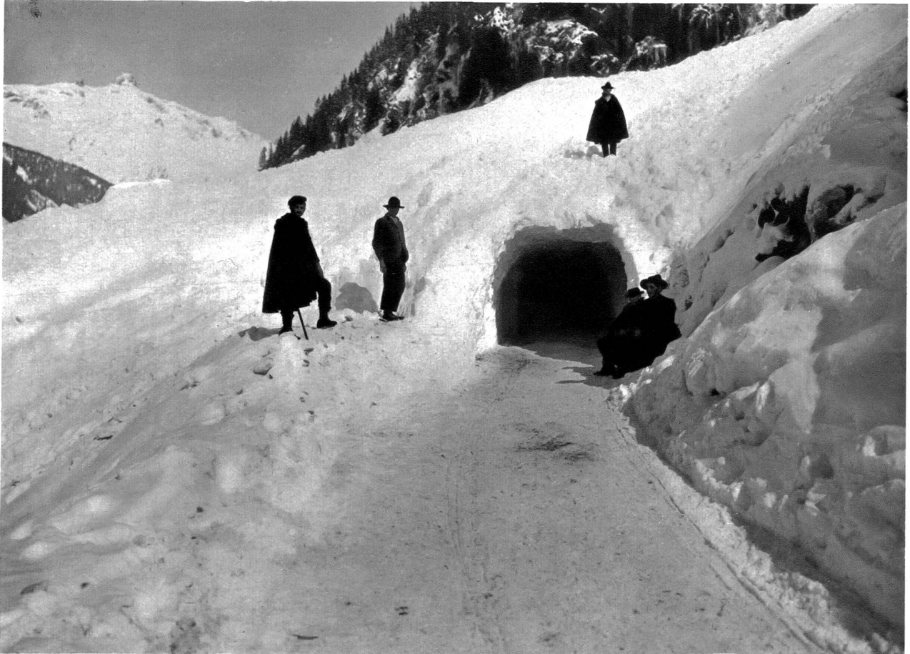
Lawinentunnel im Lötschental
