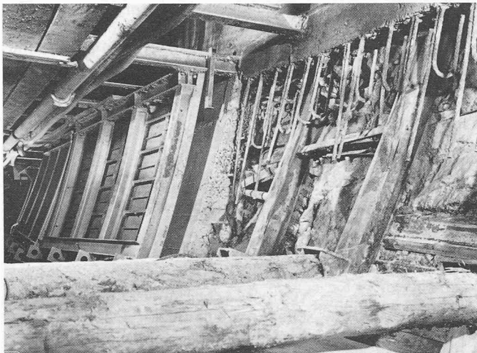
Bild 7. Betonieren der Paramente. Links: deformierte Einbaubogen, abgestützt mit Rundholzspriessen. Unten: Anschlusseisen für obere Paramentetappe. Rechts: fertig betoniertes Parament, davor Schalelement.
