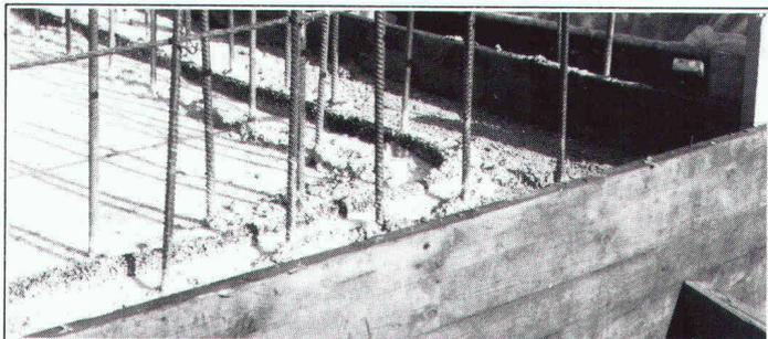
Ununterbrochene Kontinuität des Anschluss-Verbindung
