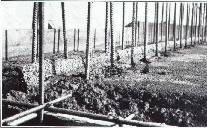
Erstellen einer Anschluss-Dichtung "BFL-MASTIX"
