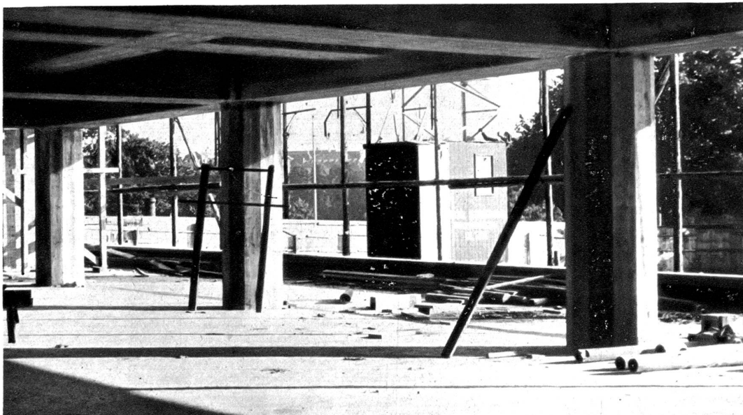
Durchblick beim Parterregeschoss. Diese Zwölfecksäulen tragen das ganze Gebäude. Sehr schwierig war die Ausführung der Fundationen auf diesem Baugelände
