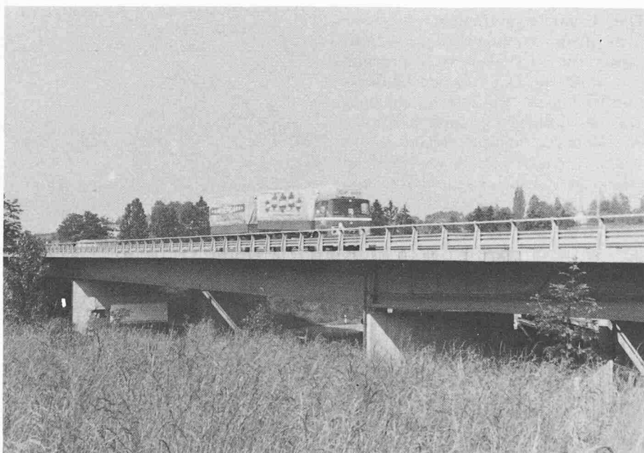
Bild 1. Pont de la Venoge, eine Verbundbrücke der Autobahn Lausanne-Genf N1, unter Verkehrslast. Siehe auch Bild 9
