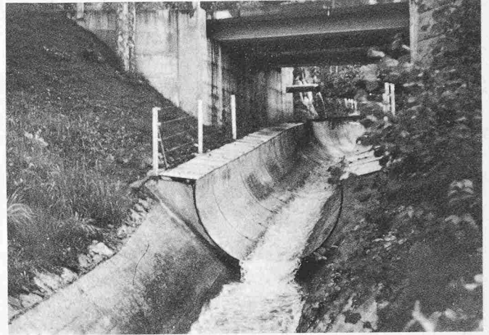
Bild 8. Mühlebach. Übergang Ortbetonschale zu Wellblechschale mit Werkstrassenbrücke
