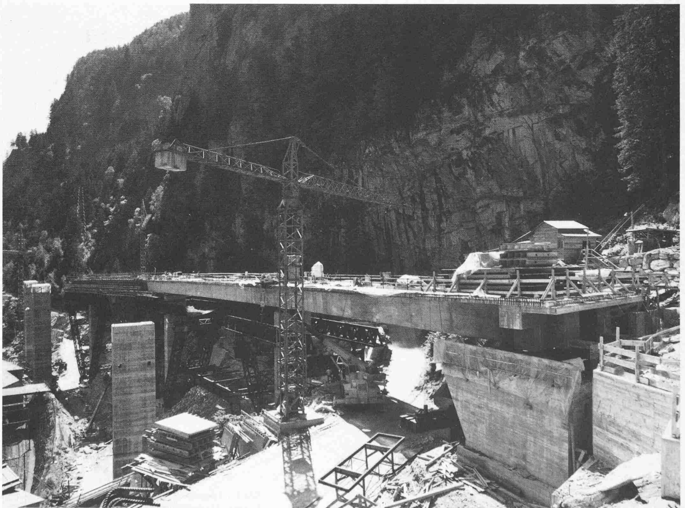
Stand der Arbeiten am 23. Juli 1980
