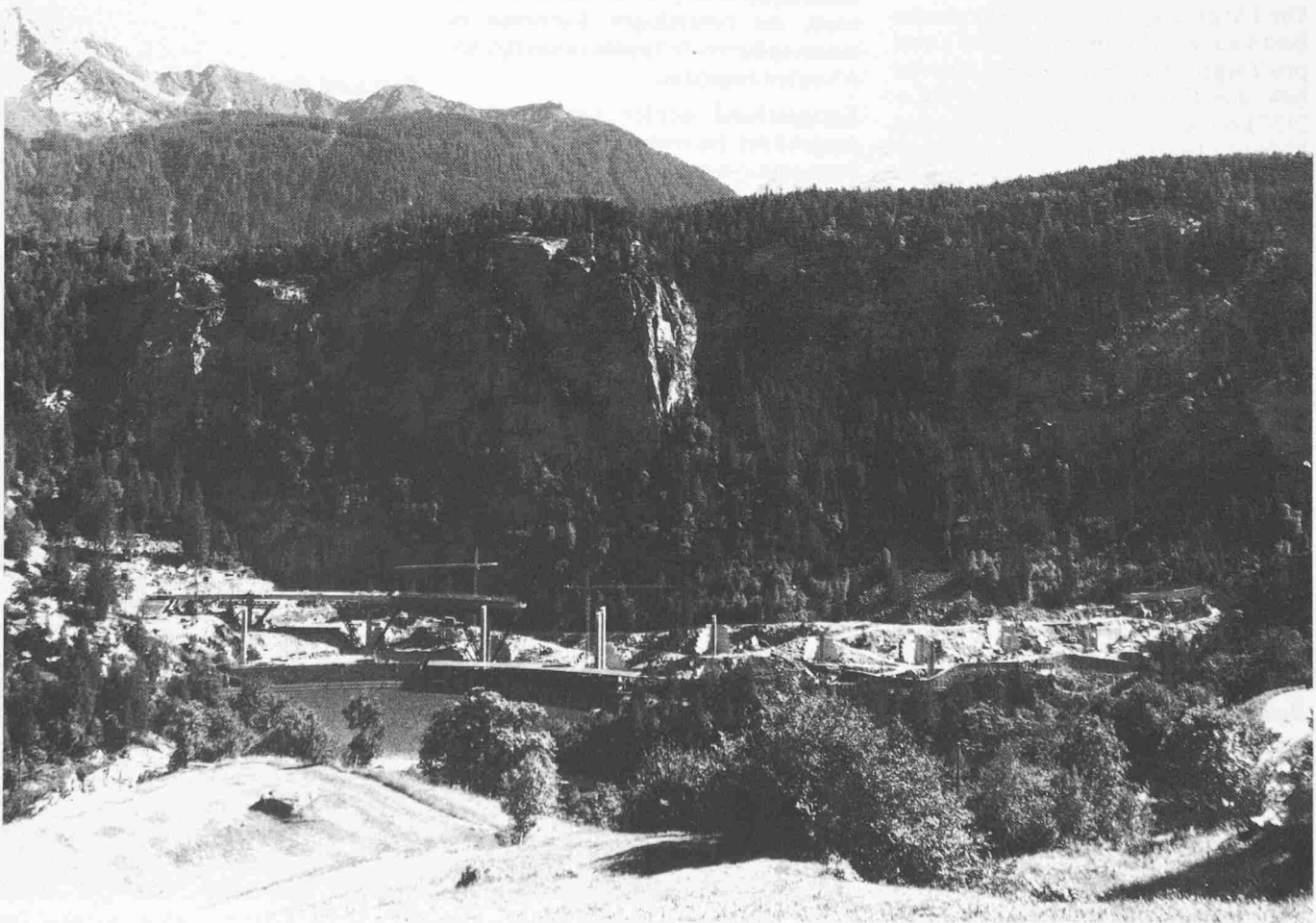
Bild 14. Stand der Arbeiten am 23. Juli 1980
