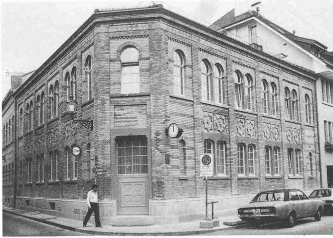
Bad und Waschanstalt von W. Bareiss, 1863, mit dem ältesten Hallenbad der Schweiz, geschlossen 1917, ungenutzt und renoviert 1980
