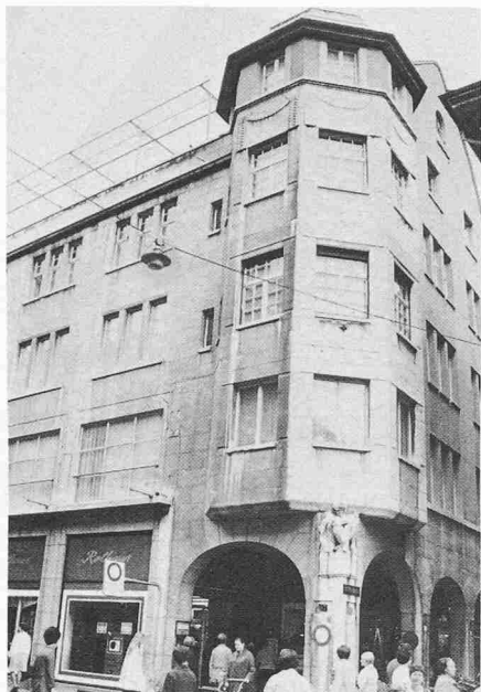
Warenhaus an der Marktgasse, erbaut 1910 von Rittmeyer und Furrer
