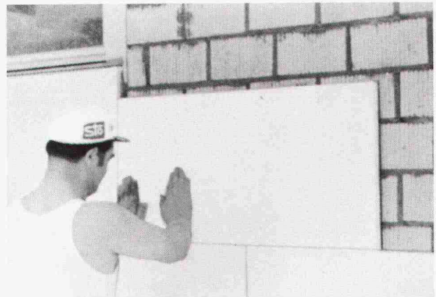
System K: Hartschaumplatten vesetzt auf Mauerwerk kleben.
