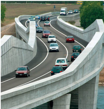
01 Ausgezeichnete Aarebrücke (SO) von Fürst Lanfranchi Bauingenieure (Foto: Fürst Lanfranchi)
