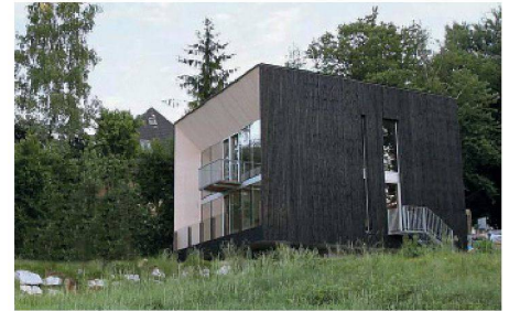
03 «Schattenbox Wienerwald»: Schwebende Holzbox am Hang mit offenem Wohnkonzept (Foto: Superreal / Dold und Hasenauer)
