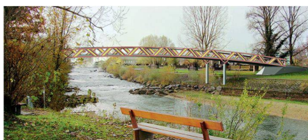
06 Zweifeldrige Fachwerkbrücke mit aussen liegendem flachbogenförmigem Diagonalfachwerk
