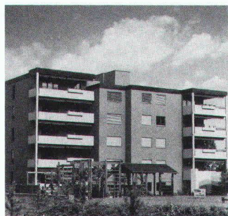
Foto: Peter Weber, BBI Bauberatung und Bauinformation
