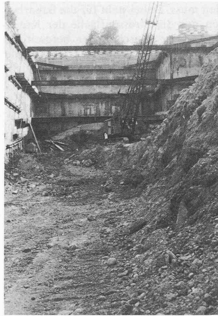
Bild 10. Portalbaugrube Seite Stettbach
