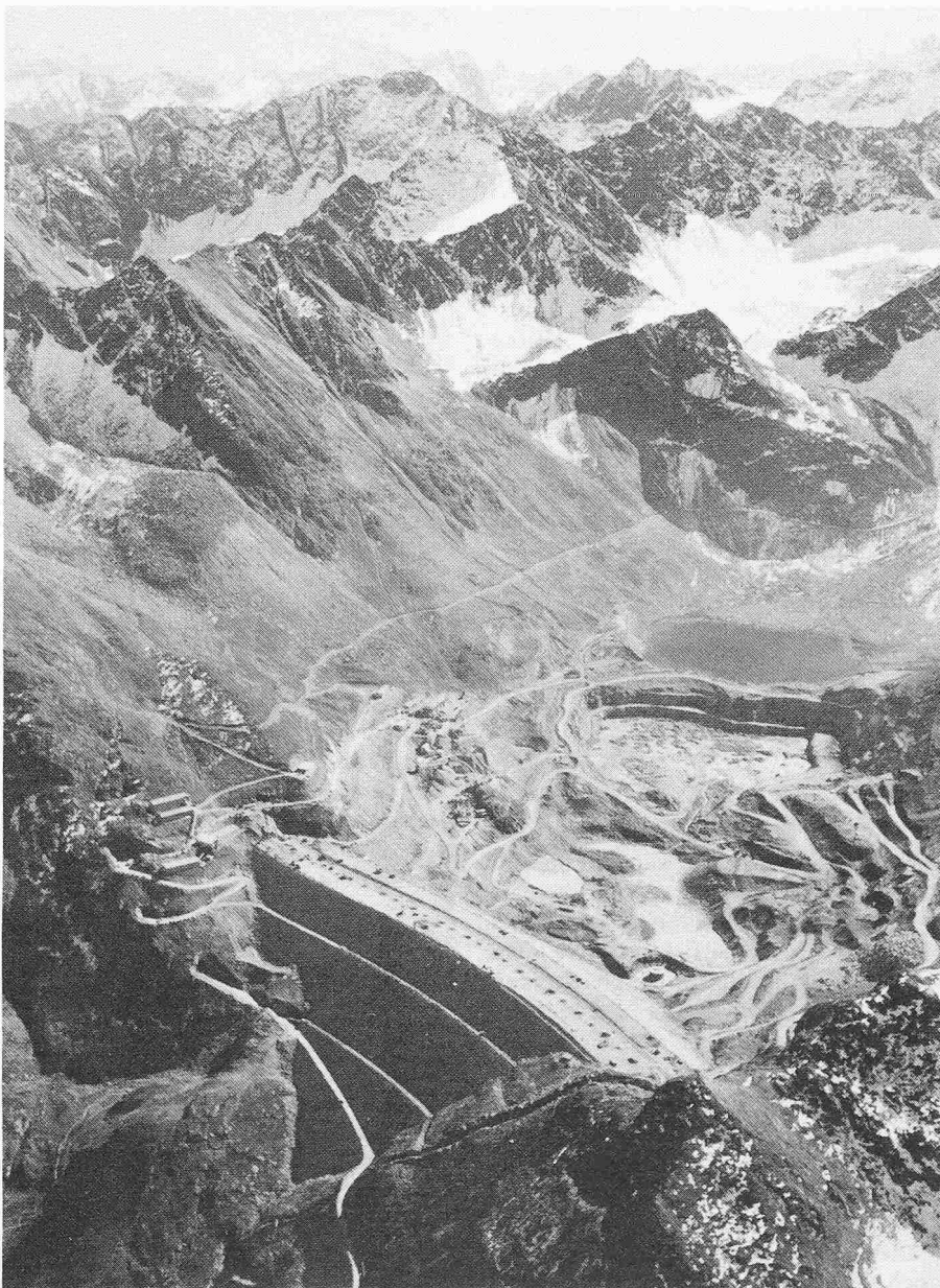
Bild 8. Staudamm für den Speicher Finstertal (60 Mio m 3 ; 2325 m ü. M.) für die Oberstufe der Kraftwerkgruppe Sellrain-Silz. Ende 1979
