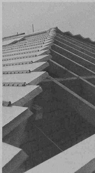
lement wird direkt auf die Dachsparren genagelt und ist sofort begehbar. Es eignet sich praktisch für jede Dachform und Ziegelart.
